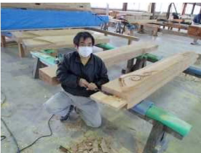
佐野棟梁が虹梁の刻みをしていました
