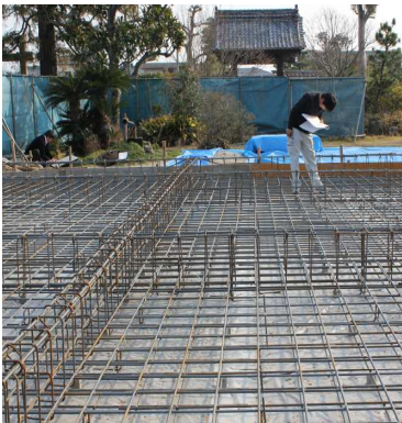
ベースW配筋と立上り鉄筋
