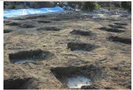
柱状地盤改良工事
