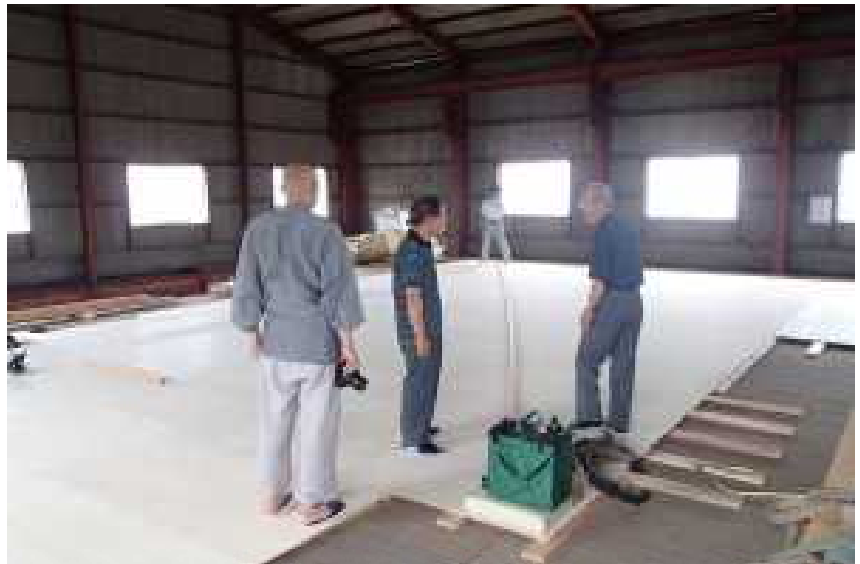
平成の時代になっても、本堂屋根の形は原寸図で微調整します
